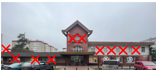
Баннеры под навесом и на фасаде Крышная вывеска Фрагментарная отделка фасада
